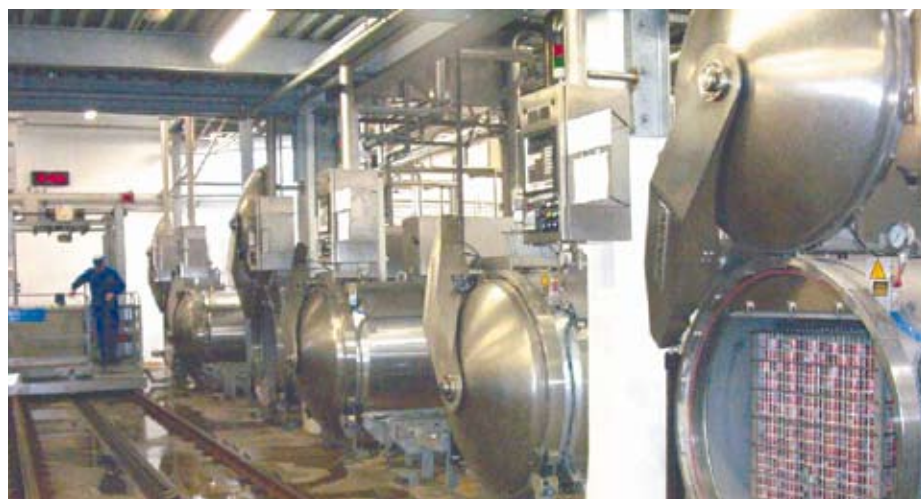
Tous les ateliers de l'usine disposent de leurs propres compteurs d'eau... c'est l'un des éléments qui, en dix ans, a permis de diviser quasiment par deux les consommations.
